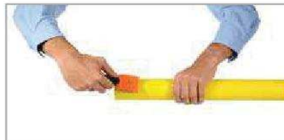
5. Gratter la zone de soudage du tube.
