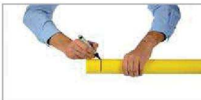
7. Marquer la profondeur d'insertion du tube.
