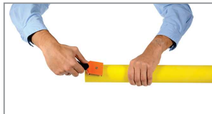
5. Gratter la zone de soudage du tube.
