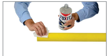
6. Nettoyer la zone de soudage avec un liquide approprié.
