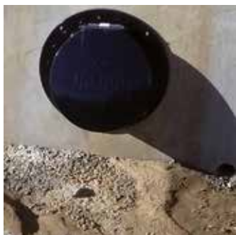
Bassin de retention
