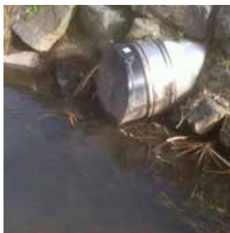
Berge de rivière sur tuyau PVC
