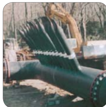
Diffuseurs d'effluents
